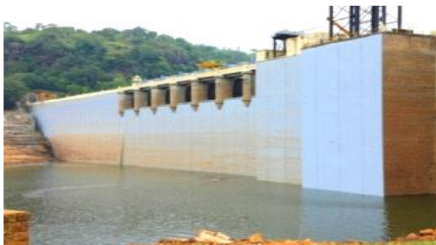
Geomembrane Lining Works
