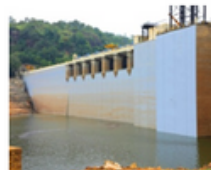
Geomembrane Lining Works
