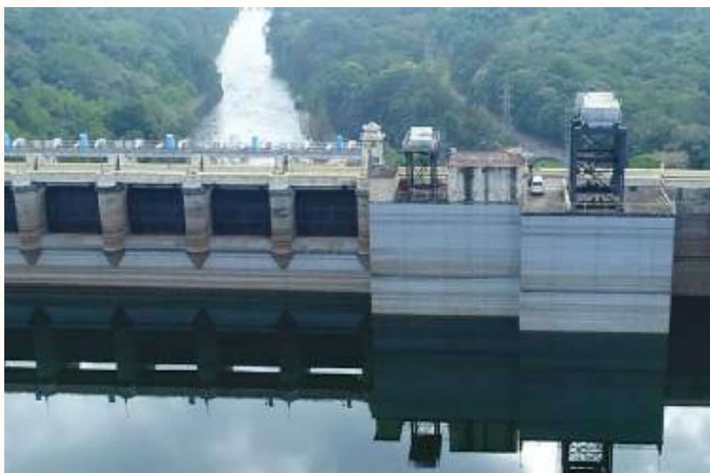
Upstream face Geo-membrane (Servarar dam, TANGEDCO)
